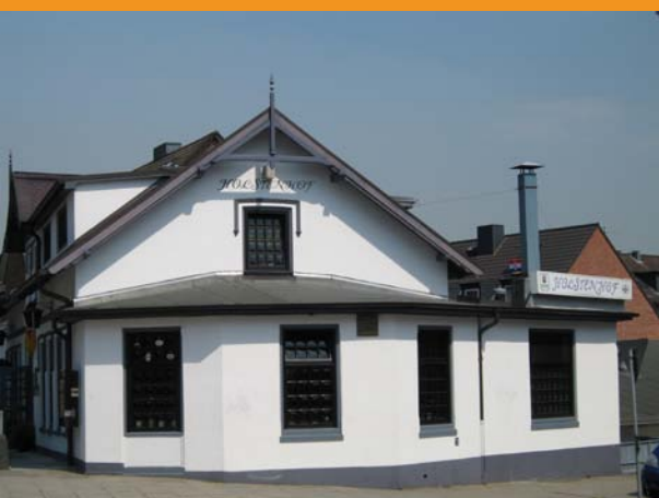
Holstenhof, Lohbrügger Landstraße
