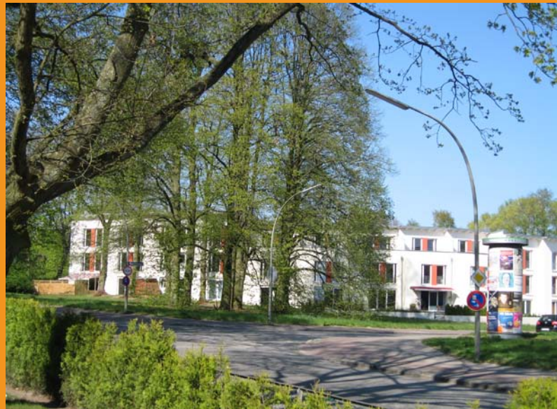
Neubauten Ecke Leuschnerstr./Binnenfeldredder - „Dorfplatz“
