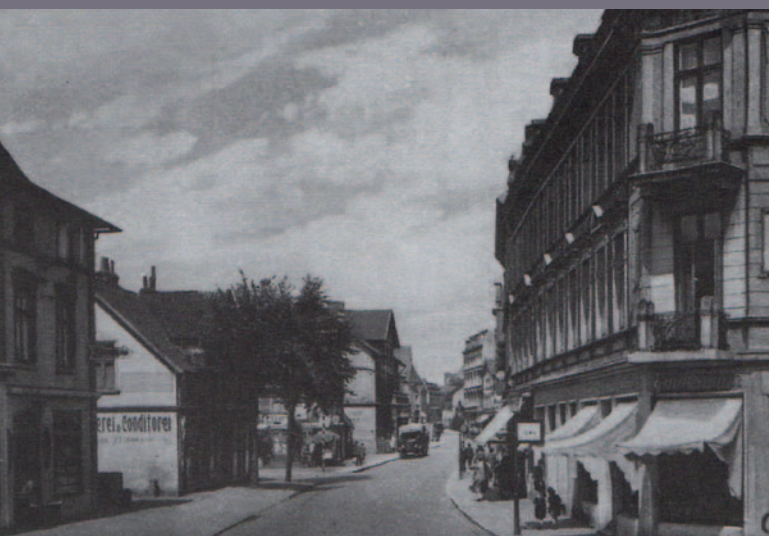
Der untere Teil der Alten Holstenstraße, heute befahrbarer Teil aus Richtung Bahnunterführung.
