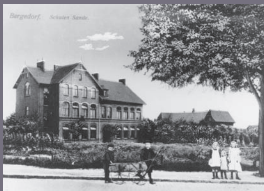
Die beiden Mädchenschulhäuser an der Stelle der heutigen Schule.
