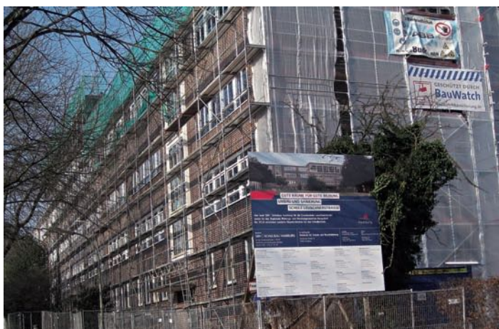
Die Schule Leuschnerstraße wird saniert.
