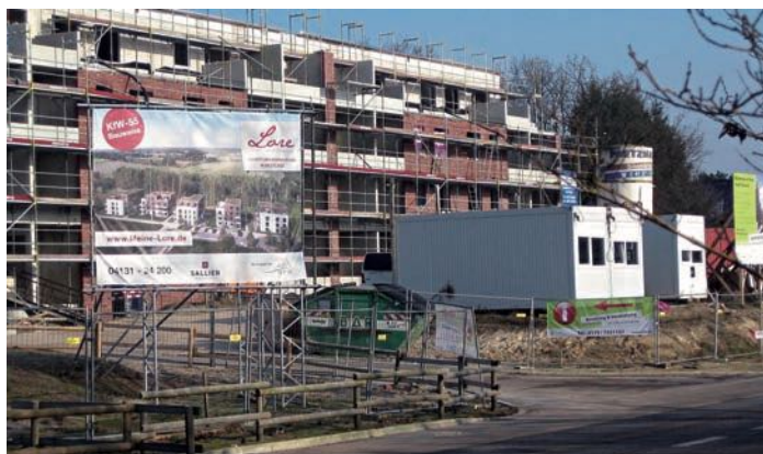
Am Reinbeker Redder ist der Baufortschritt gut!
